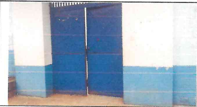
Foto 5: Mantenimiento de porton de metal
