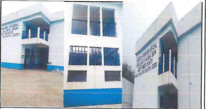
Foto 6: Mantenimiento de barandas de metal
