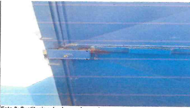
Foto 3: Sustitución de chapas de puertas
