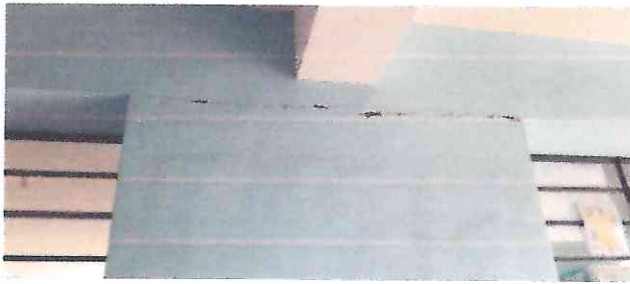
Foto 1: Impermeabilización de losas
