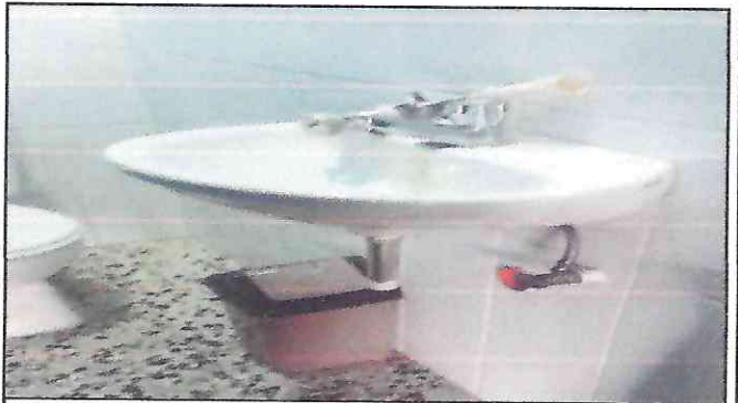
Foto 4: Sustitución de lavamanos
